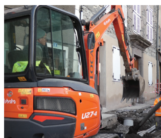
Réfection de chaussée Avenue des 12 et 24 juin
