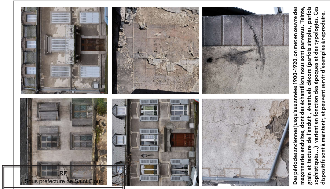
Recrépir est de nature à faire réapparaître des dispositions architecturales actuellement occultées. Le doute n'est pas ici permis (immeuble de type classique tardif aux encadrements en saillie). On peut même imaginer sur ce type d'immeuble très soigné, le retour d'un décor.
